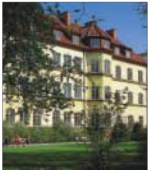
Allmänna Sjukhusets äldsta byggnad är från 1896.
