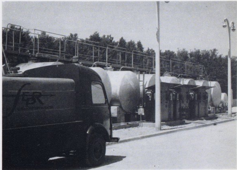
Installations fixes à Villaroche (cuvées de 10.000 l. TX).
