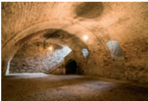
An den Turm anschließender Lagerraum: heute für Kulturveranstal- tungen genutzt
