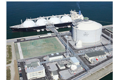
石狩LNG基地写真
