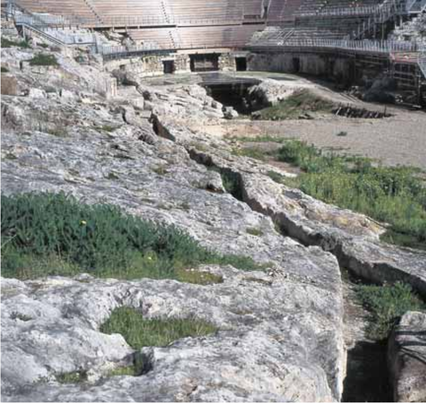
Fig. 32. Tratto sud-orientale dell'euripus, il collettore delle acque piovane raccolte sulle gradinate e gli immediati dintorni della cavea.
