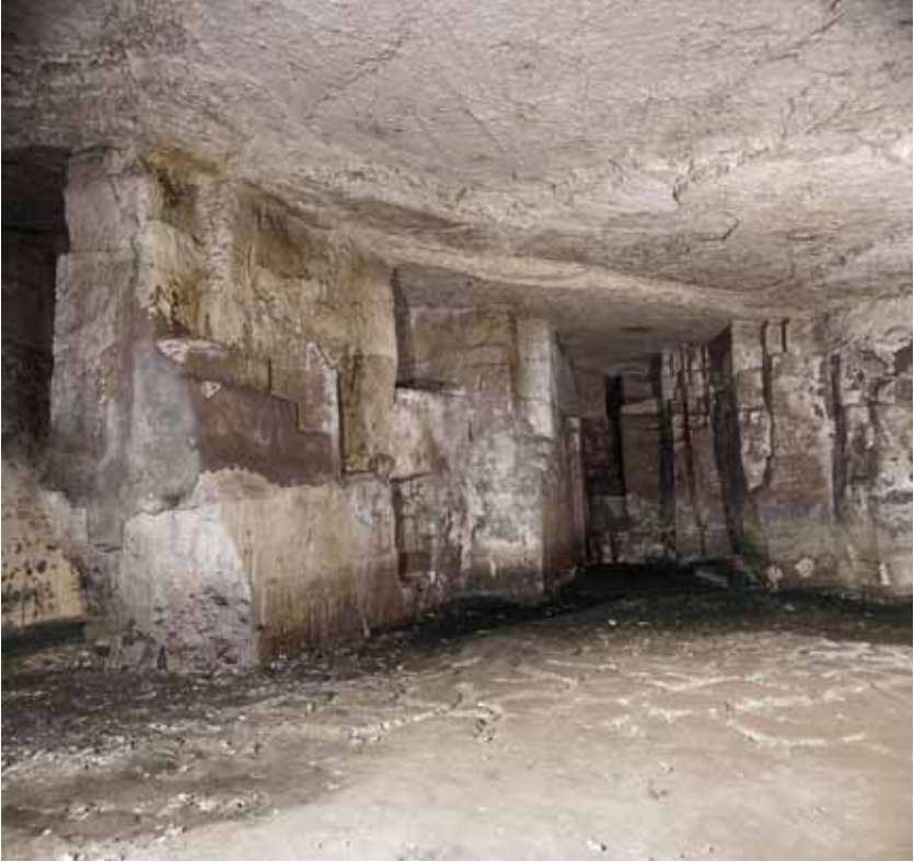
Fig. 35. Settore orientale del cisternone “Vittorio Emanuele”, nell’Orto dei Cappuccini. Sulle pareti di questa antica latomia, in parte ancora ricoperte di cocciopesto impermeabilizzante, si osservano le tracce della cava di blocchi originaria. In alto sullo sfondo, in posizione centrale, si apre l’imboccatura dell’ampia galleria che, attraverso 96 metri di roccia calcarea, raggiunge direttamente l’arena dell’anfiteatro.
