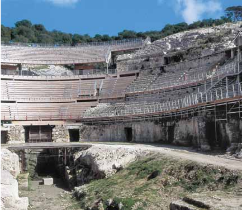
Fig. 24. Sezione delle fossae dal fulcro meridionale dell'arena. In primo piano i due nuclei di fondazione del settore sud-occidentale della cavea, in conglomerato cementizio.
