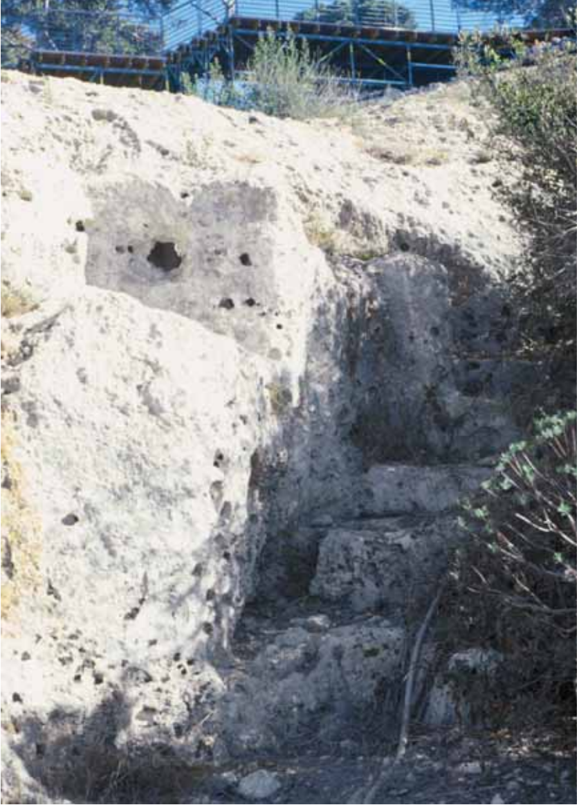
Fig. 28. Scala di servizio e anellone di ancoraggio per le sartie del velarium, nel settore orientale all'esterno dell'anfiteatro.
