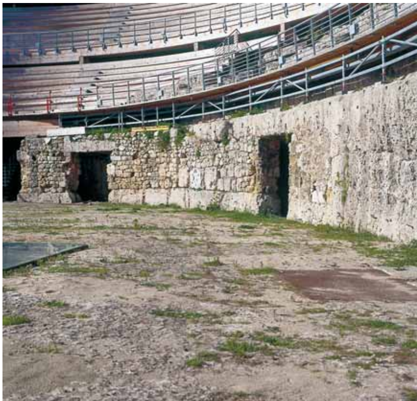
Fig. 16. Muro di cinta dell'arena, in gran parte ricostruito negli anni Trenta del secolo scorso dal soprintendente Doro Levi, con alcuni degli ingressi minori alle cryptae.
