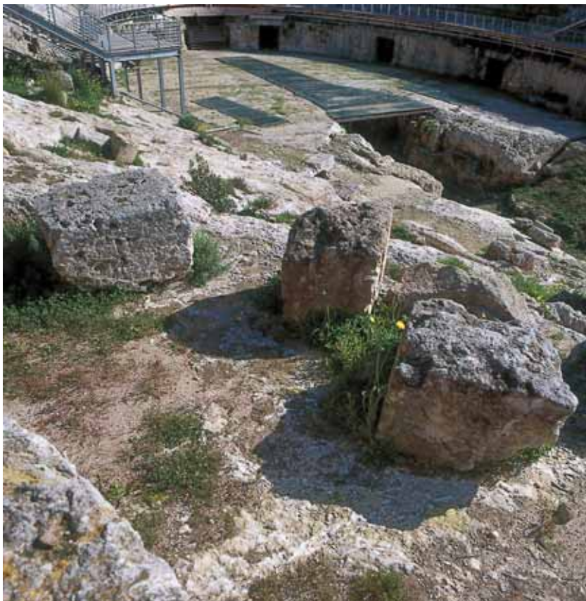
Fig. 6. Blocchi calcarei con decorazione a bugna, provenienti verosimilmente dalla muratura esterna.
