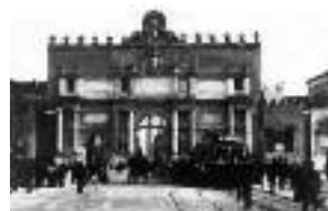
Costruzione della stazione Flaminia sulla linea Roma - Viterbo
