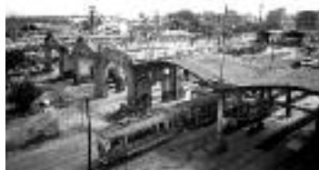
Deposito di Porta Maggiore
