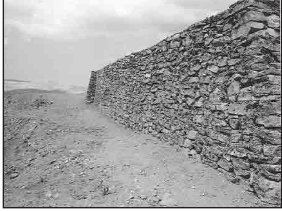
Resim 4: Sarayın onarılan kuzey duvarları, batıdan
