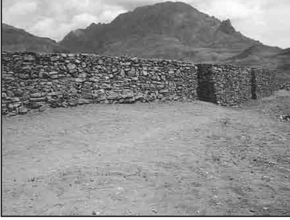
Resim 7: Sarayın onarılan güney duvarları, güneybatıdan
