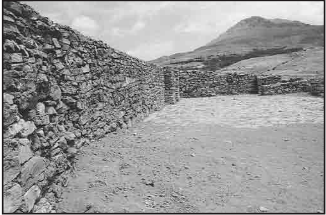
Resim 8: Sarayın onarılan güneydoğu duvarları, güneyden
