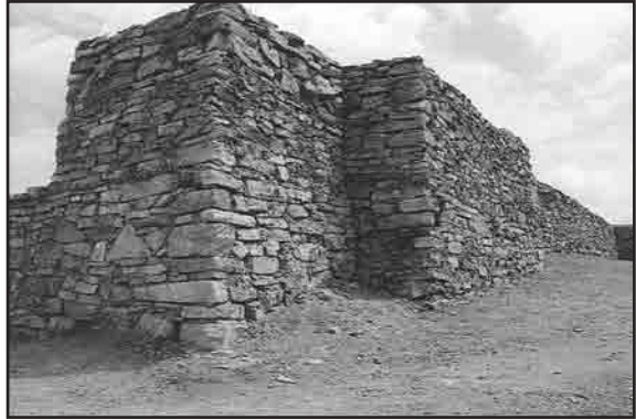
Resim 6: Sarayın onarılan güneybatı duvarları, güneyden
