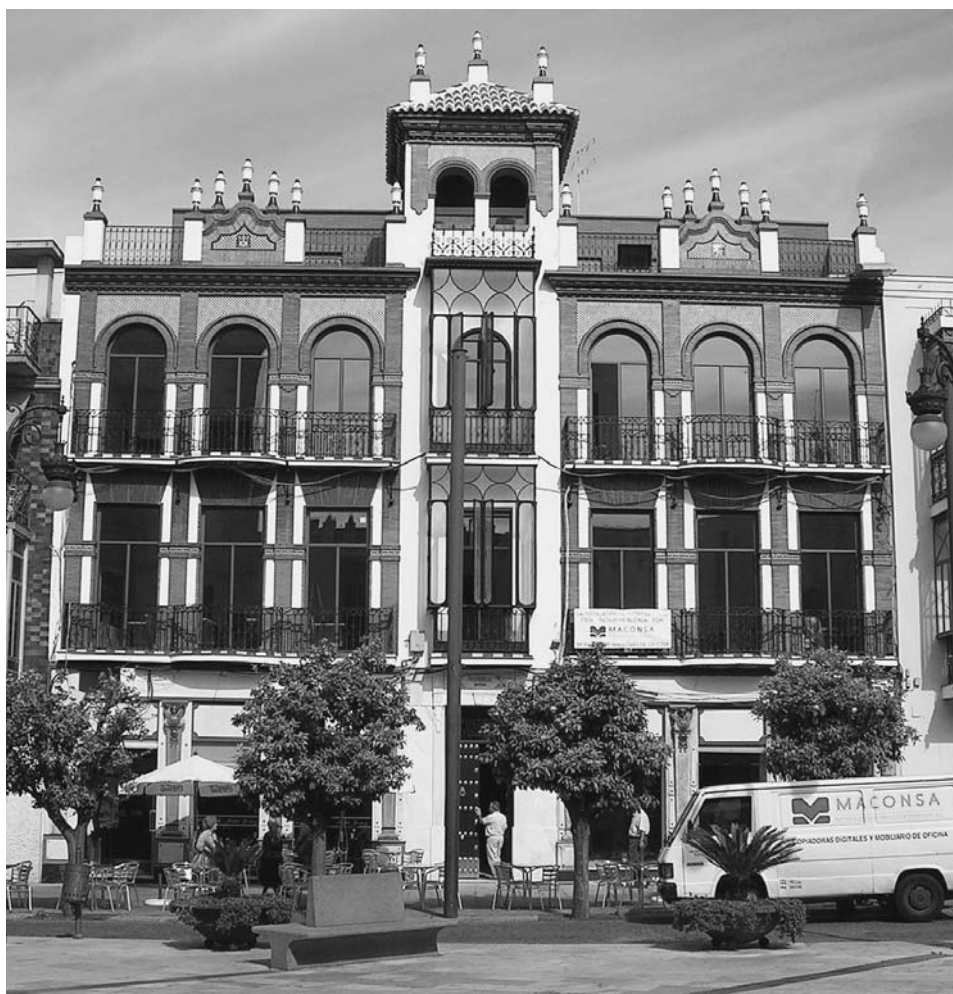
FIG. 5. Casa Álvarez Buiza en la actualidad, construida en 1919.
