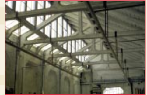
Copertura a shed (Foto ITIS GALILEI).
