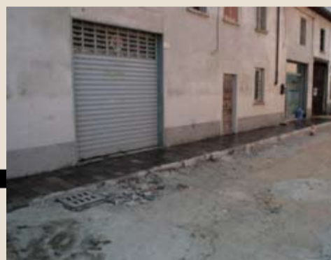
1 agosto 2011 Inizio posa nuovi marciapiedi
