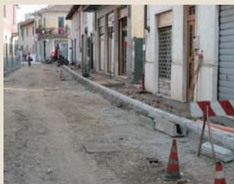
26 luglio 2011 Posa cordoli marciapiedi
