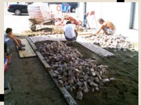
8 agosto 2011 Inizio posa cubetti di porfido
