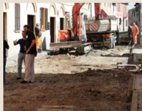
20 luglio 2011 Fine scarifica I lotto
