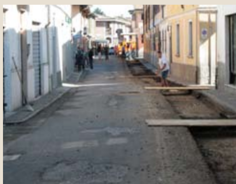
20 luglio 2011 Primo giorno di lavori
