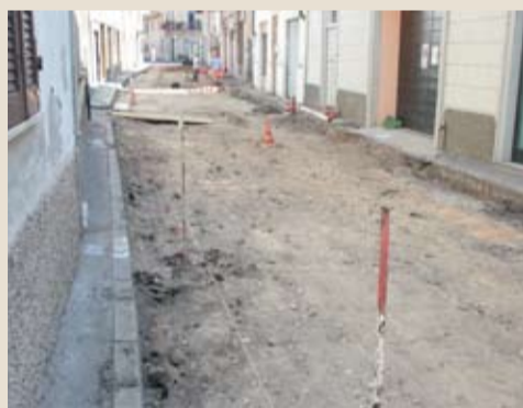
21 luglio 2011 Tracciatura marciapiedi
