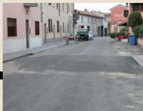
10 ottobre 2011 Conclusione lavori terzo lotto
