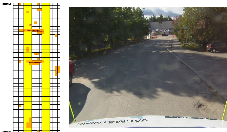
Kuva 8. Vauriotulkinta, APVM, VO%, 5.9 %.
