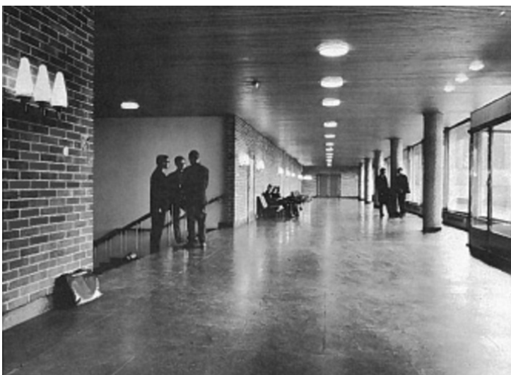
Korridor i sentralhall i 1963. Foto: Øivind Berger. Opphavsrett: NHH.
