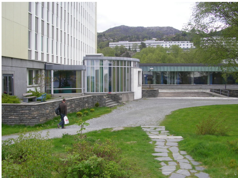
Hovedbygning, fasade mot vest. Høyblokk og kommunikasjonslinje til høyre. Studenthjemmet Hatleberg i bakgrunnen. Opphavsrett: Statsbygg.
