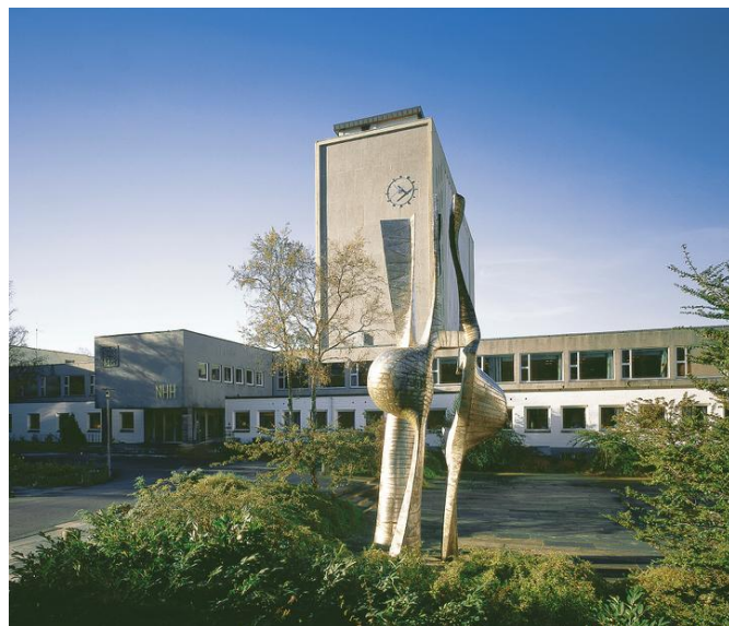
Hovedinngang/høyblokken. Opphavsrett: NHH.
