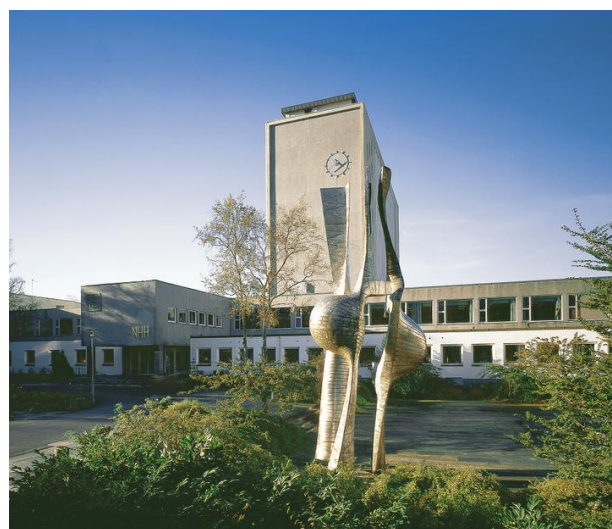
Hovedinngang/høyblokken. Opphavsrett: NHH.
