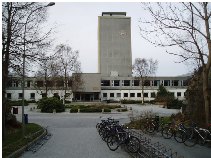
Hovedadkomst, med hovedinngang, sentralhall og instituttblokk. Opphavsrett: Statsbygg.
