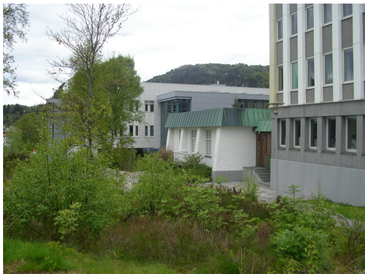
Stupet, fasade mot sør-vest. Høyblokk til høyre, og servicebygg til venstre. Opphavsrett: Statsbygg.
