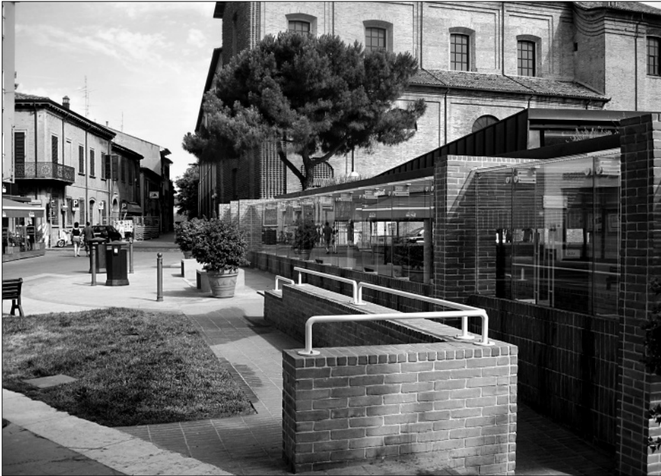
Fig. 5. La struttura di protezione realizzata sulla domus del Chirurgo di Rimini.
