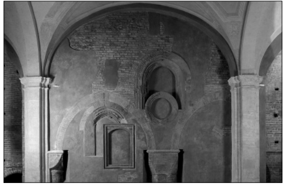
Fig. 3. Campata centrale della parete nord, con le finestre trecentesche e quattrocentesche aperte nel muro di tamponamento del portico trecentesco e mantenute in vista dai restauri di Alfredo d'Andrade del 1884.
