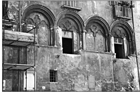
Fig. 6. Susa, Casa de' Bartolomei, la facciata con la loggia.
