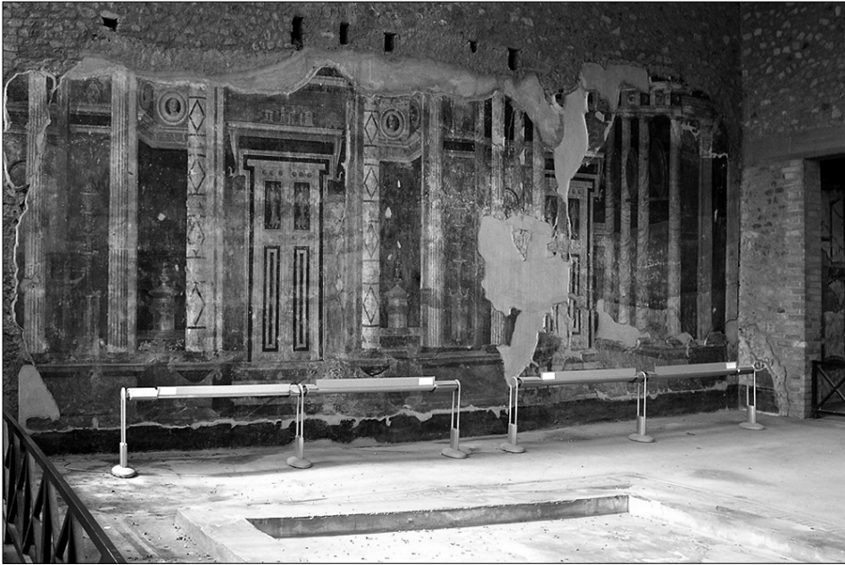
Fig. 12. Esempio di sistema di illuminazione integrato nell'allestimento, Villa di Poppea, Oplontis.
