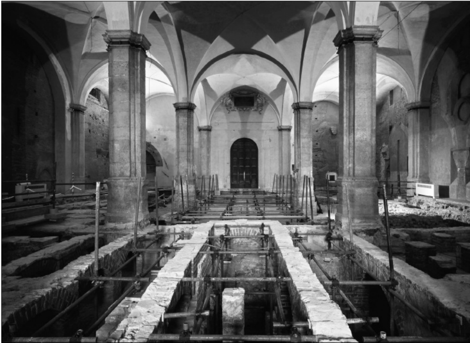
Fig. 5. Lavori di scoprimento dello scavo di Alfredo d'Andrade.
