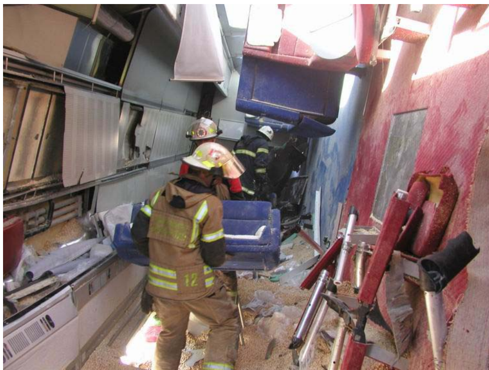
Utrensning av lös inredning i vagn A. Vagnen ligger på höger sida. Foto: Kalle Josefsson, Wennergrens Maskin AB.
