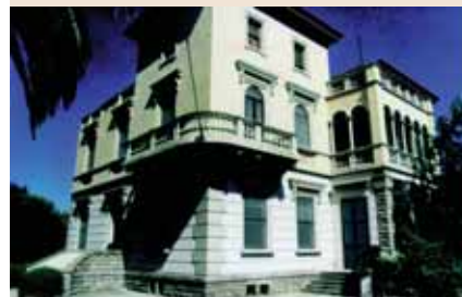
Bonifiche – Arborea. La palazzina della direzione della Società Bonifiche Sarde che realizzò la trasformazione e la messa a coltura della vasta piana di Su Sassu.
