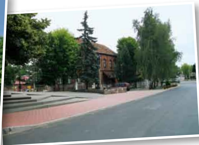
Modernizacja chodników w centrum
