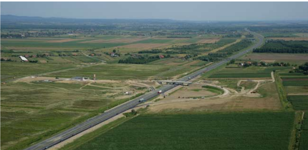
Slika 16. Gradnja čvorišta Križ – stanje radova ljeti 2007.
