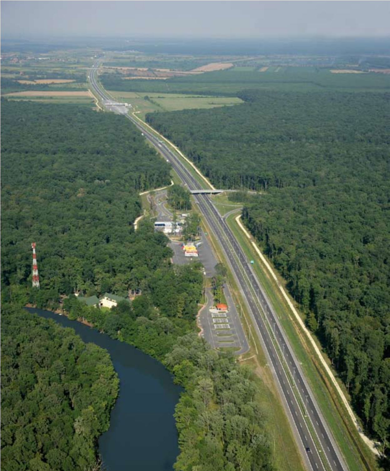
Slika 13. Pogled na trasu autoceste A3 kroz Spačvansku šumu.
