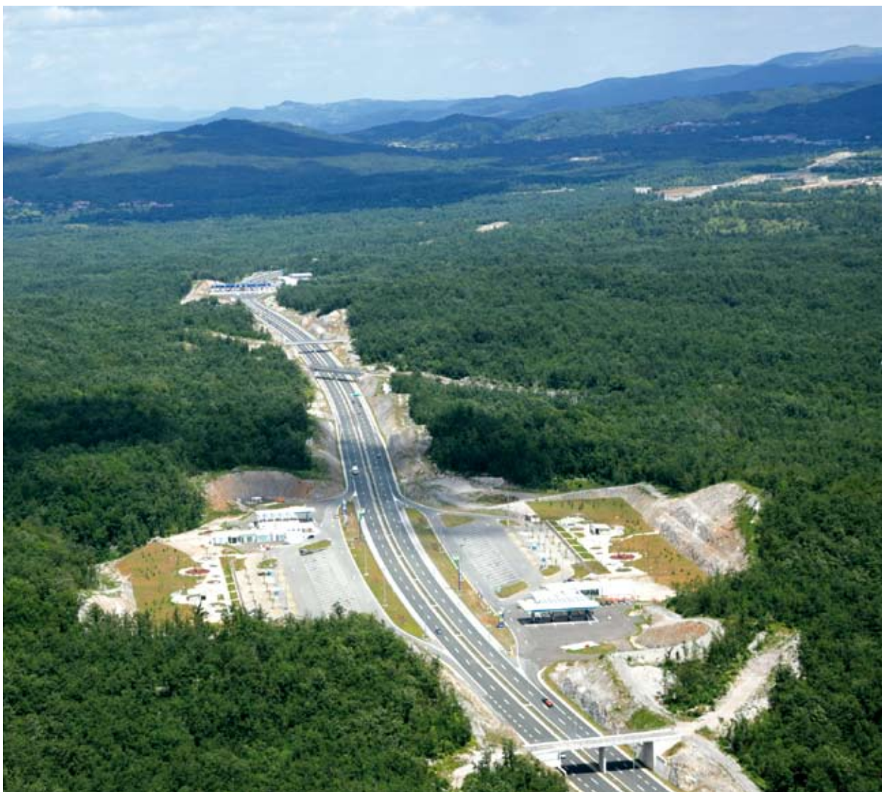
Slika 23. Fragment dovršenog dijela autoceste A7 u blizini graničnog prijelaza Rupa.
