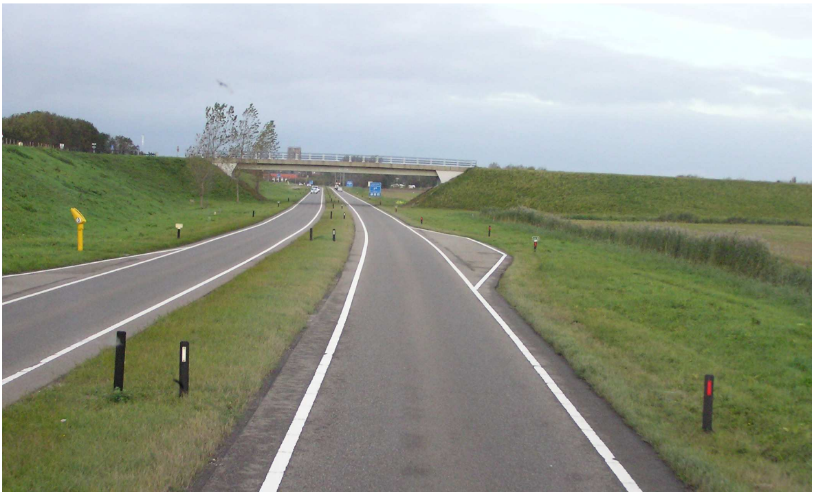
Joonis 4 Eraldusribaga kahe- ja kolme-rajaline tee Hollandis
