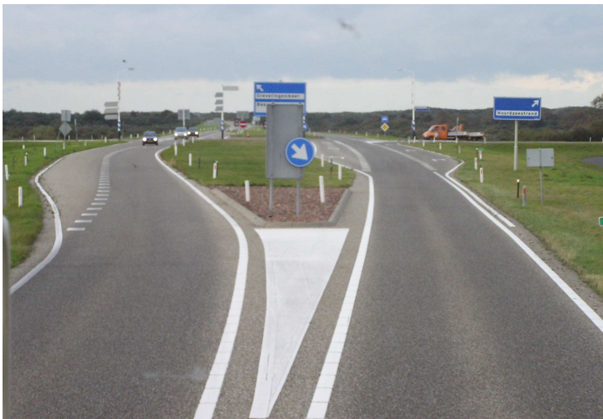
Joonis 6 Konfliktpunktide hajutamine samatasandilisel ristmikul eraldussaarega
