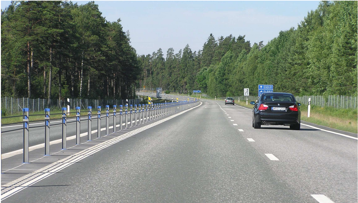
Joonis 5 Eraldatud sõidusuundadega 2+1 tee, Jönköping-Göteborg maantee Rootsis
