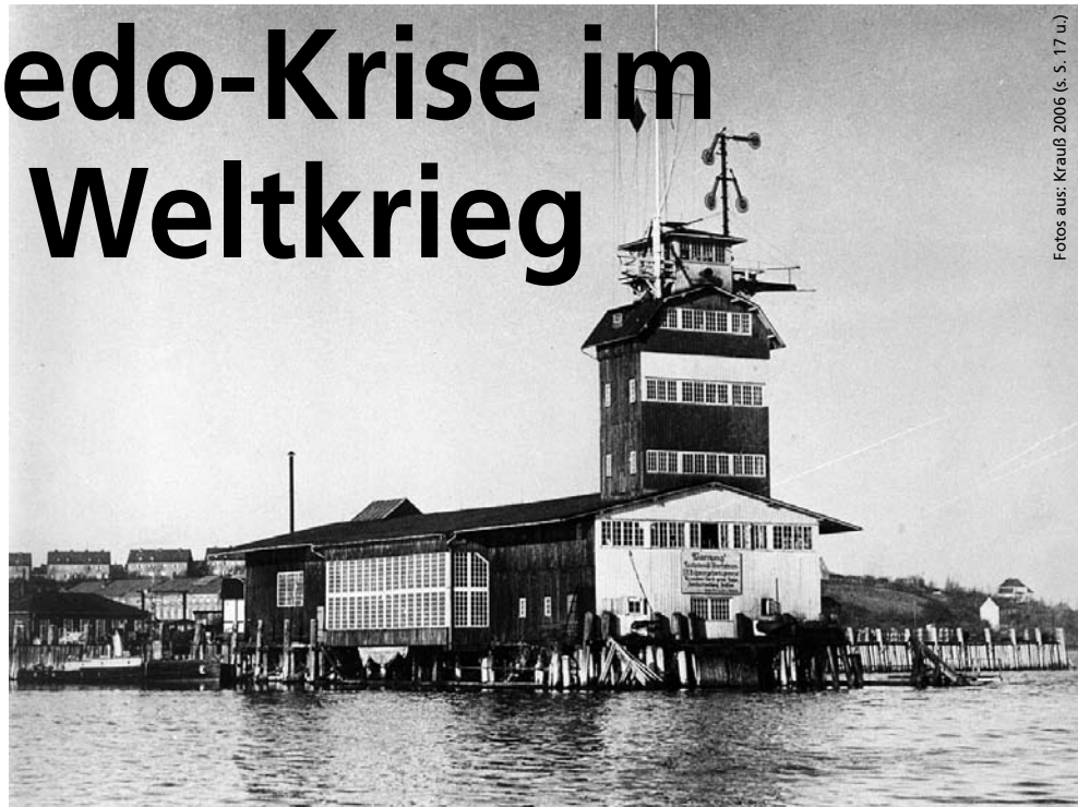
▲ Torpedoschießstand der Torpedoversuchsanstalt Eckernförde Süd, etwa 1935. Der Bau wurde später wesentlich modernisiert und erweitert. Vom Turm aus wurde der Lauf der abgefeuerten Versuchstorpedos beobachtet.
