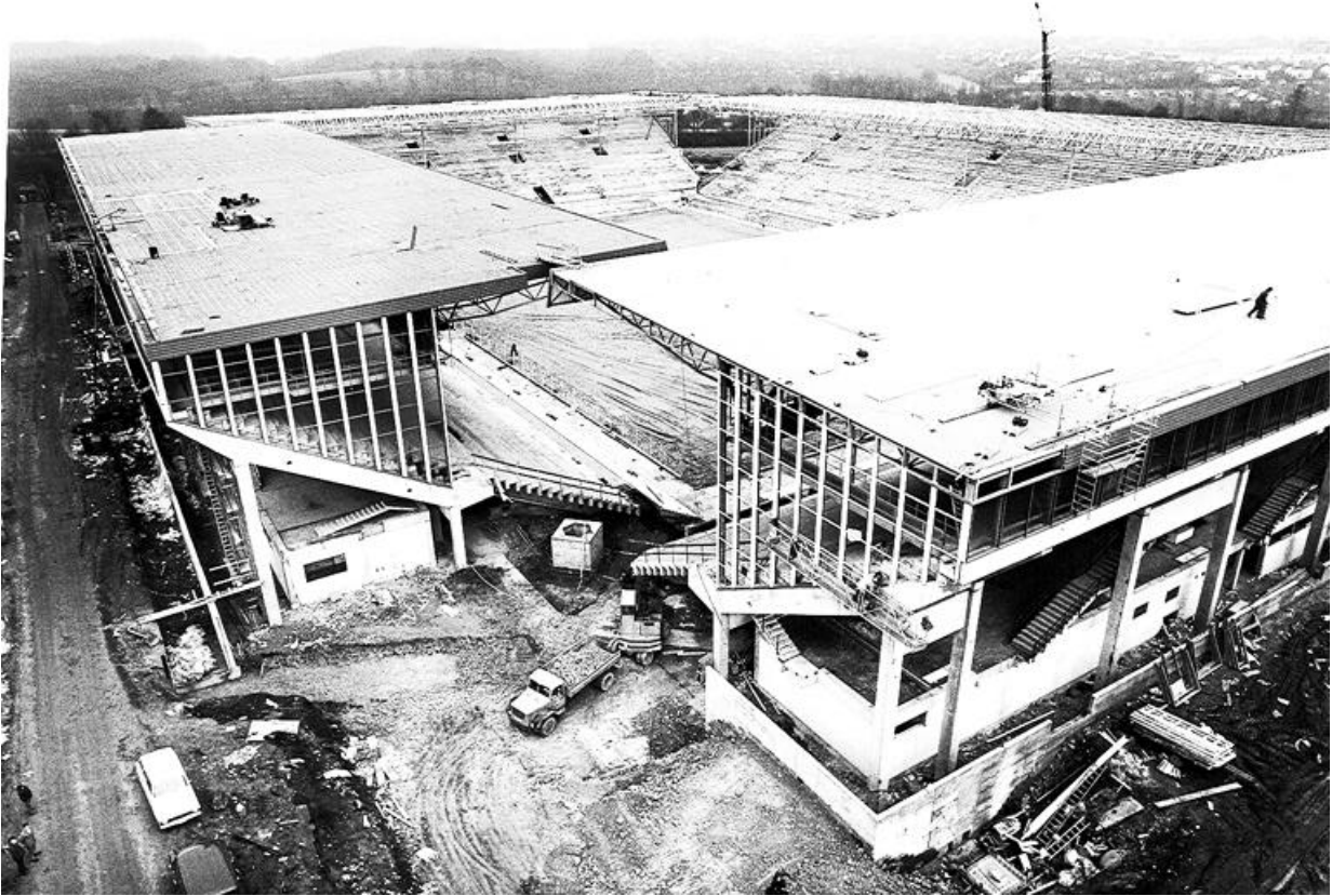
Die Westfalenstadion-Baustelle aus der Vogelperspektive kurz nach dem Richtfest 1973. Foto: RN-Archiv.
