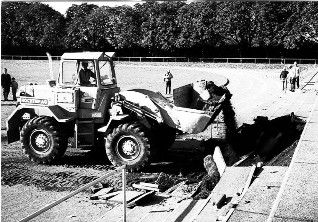
Nicht mit dem Spatenstich, sondern mit einem ersten „Baggerhub“ begann der Stadionbau am 18. Oktober 1971. Foto: RN-Archiv
