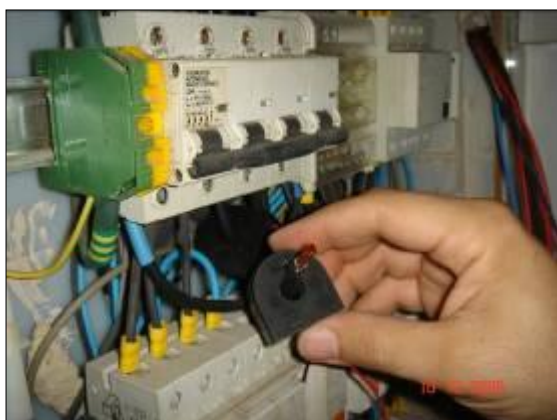
Ejemplo de Trafo incluido de 100 A (p. ej. para pequeño comercio) Relación de transformación → 5/5
