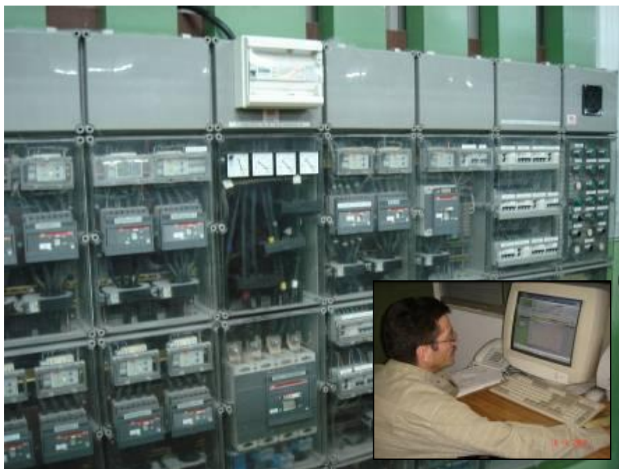
GCE monitorizando el gasto eléctrico de una línea de producción: Localización y eliminación de los consumos eléctricos no deseados. Transformación del gasto eléctrico de tipo fijo a variable.
