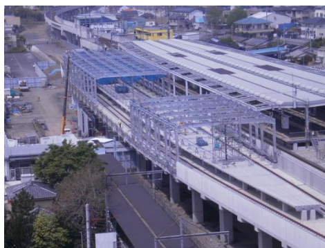
伊勢崎駅付近高架化工事
