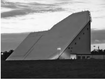
Figure 19-4. AN/FPS-85 PAR at Eglin AFB. (USAF photo)
