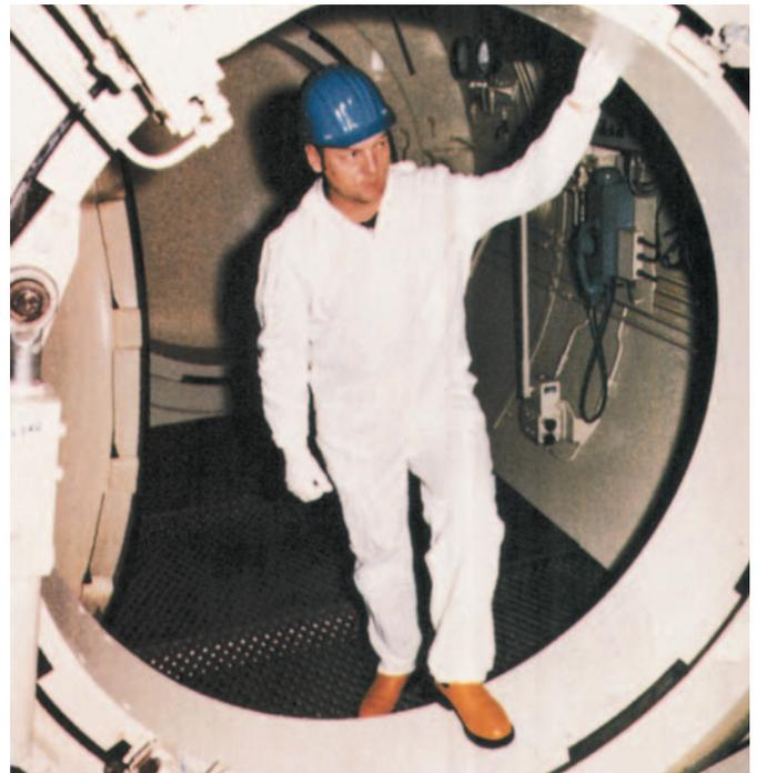
Abb. 7.13: Personenschleuse in einem Kernkraftwerk
