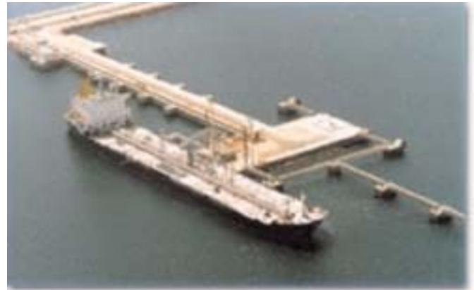
Ras Laffan—Liquid Products Jetty (Berth 2A/2B)
