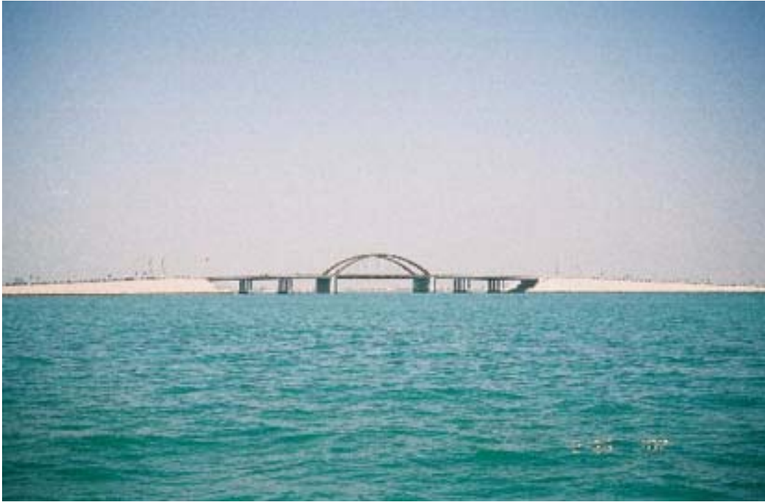
Mina Salman—Khawr al Qulayah Bridge
