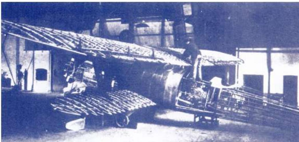
Ilustración 2. El Breguet 19TR «Jesús del Gran Poder» durante su construcción en la factoría CASA en Getafe
