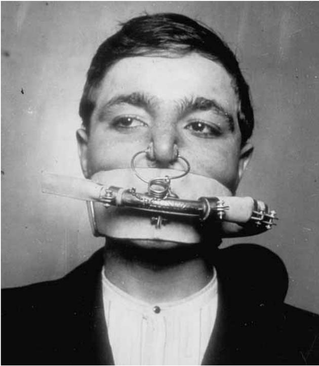
Fig. 4 - Particolare del boccaglio Fernez con a destra l'attacco della manichetta di alimentazione aria ed a sinistra la valvola si scarico a "becco d'anatra"
