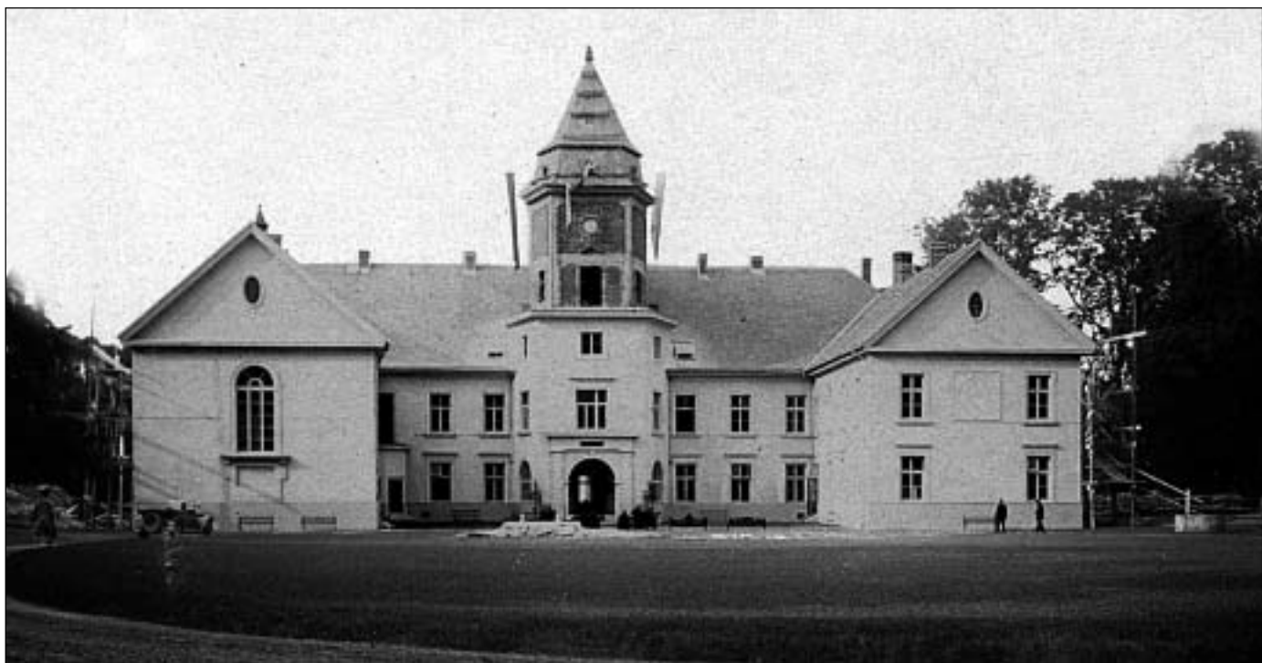
Końcowe prace przy odbudowywanej wieży zamkowej
