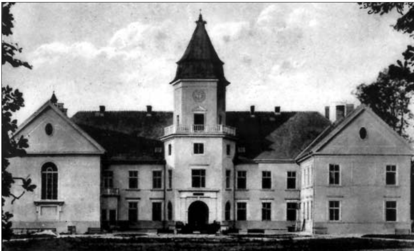
Zamek po odbudowie
