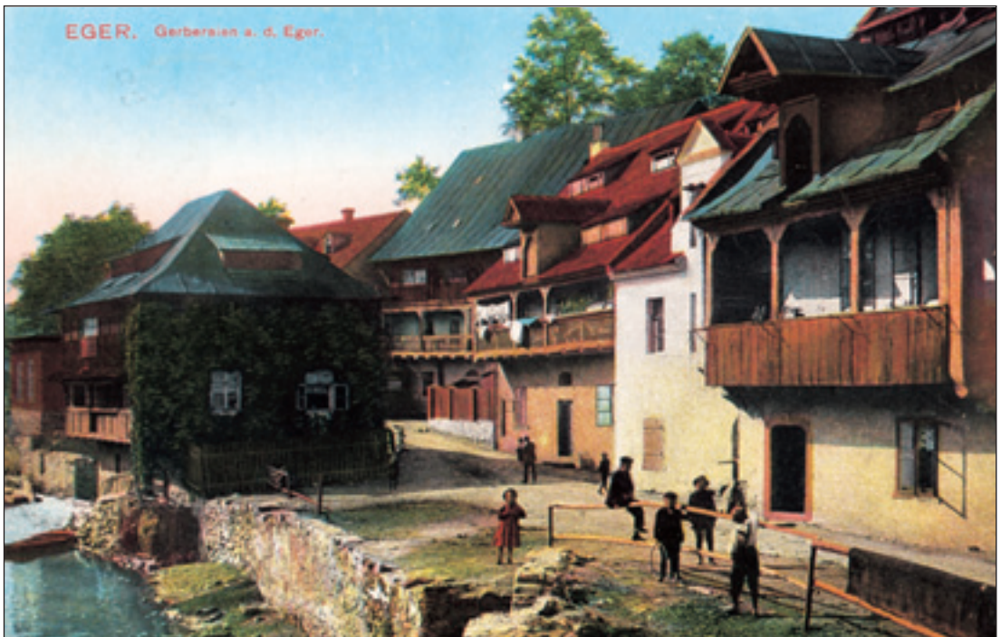
Die Stadt Eger, am gleichnamigen Nebenfluß der Moldau gelegen, war mit seinen Eisengießereien, Webereien und Brauereien ein Zentrum der Industrie. Eine Handels- und Gewerbekammer bezeugten die Bedeutung der Stadt als Handelsplatz. Das Bild aus der Monarchiezeit erinnert an die an der Eger gelegenen Gerbereien.
