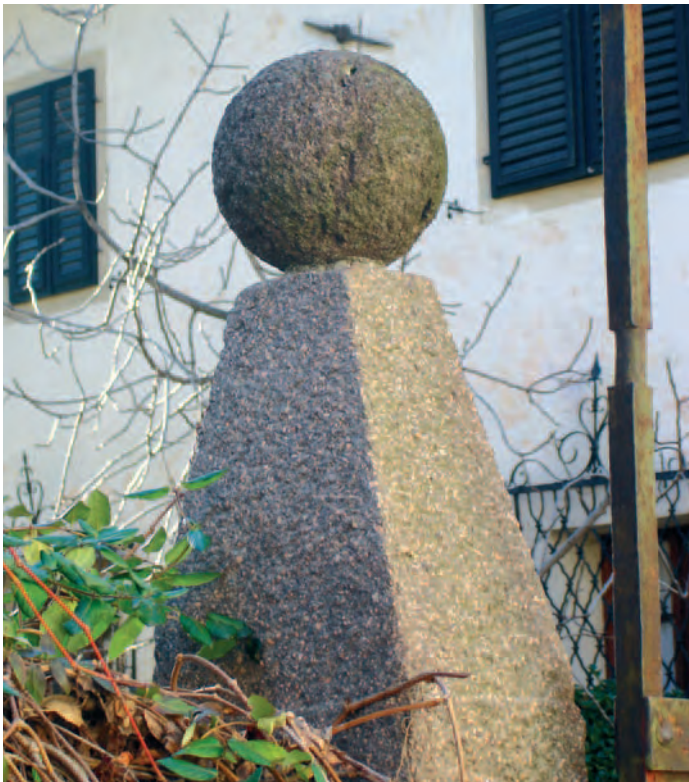
Detail des kleinen Porhyrpfeilers.
