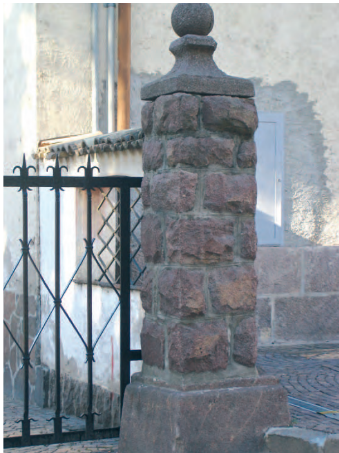
Un tipico pilastro con blocchi di porfido "bugnato".
