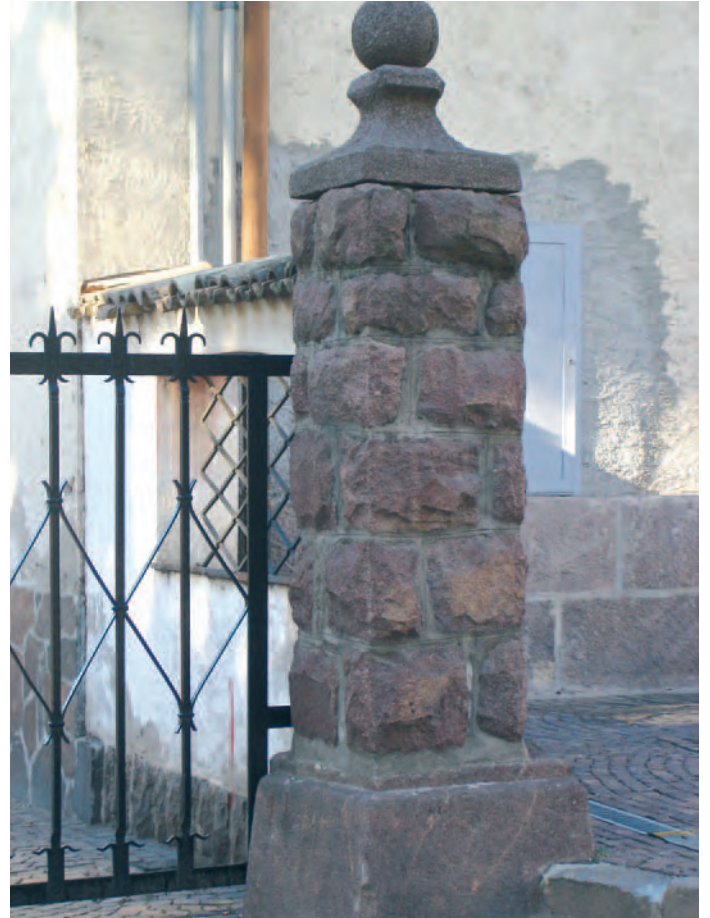
Ein typischer Pfeiler mit Blöcken aus rustikal bearbeitetem Porphyr.
