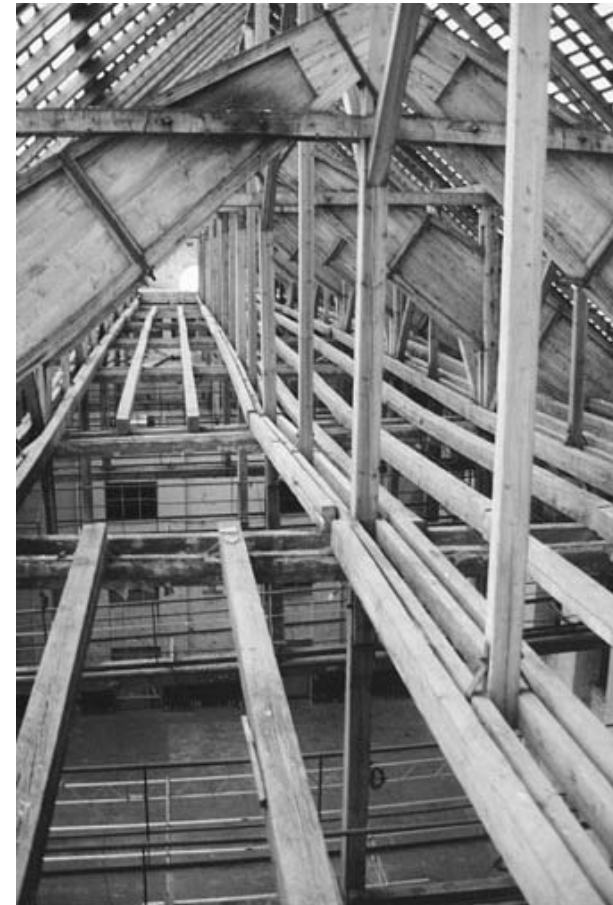
Dachstuhl über dem großen Saal - Blick nach Süden (Mai 1996)
