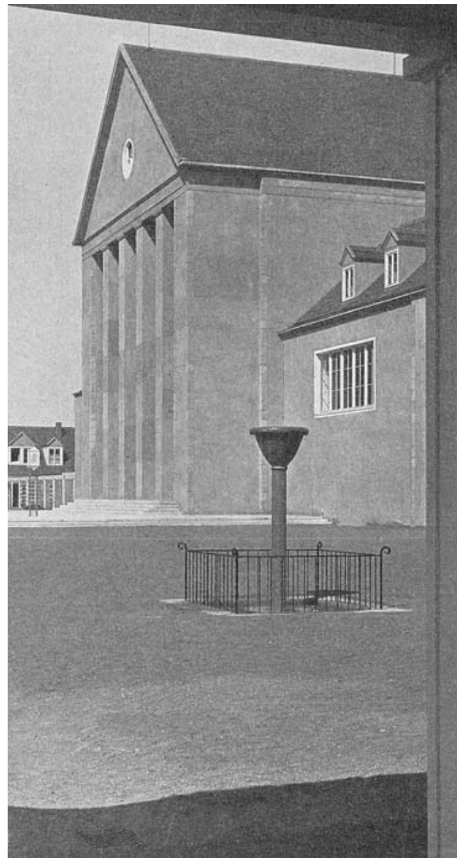
Die Bildungsanstalt von Südosten (1913) [Tessenow, S. 126]
