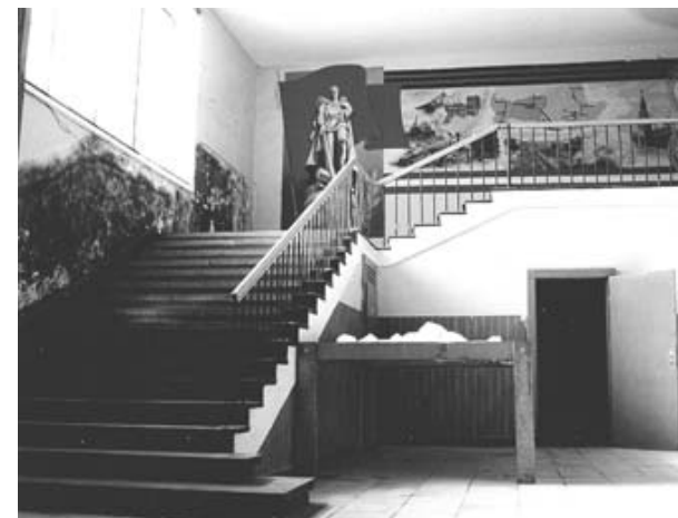
Treppenhalle R1.04 (Feb. 1996)
