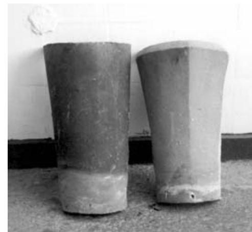
Auf dem Dachboden gefundene Firstziegel
