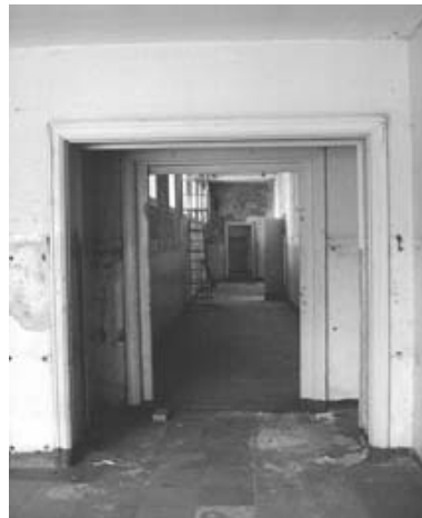
Blick in den Flur R2.05 von R2.02 (Feb. 1996)
