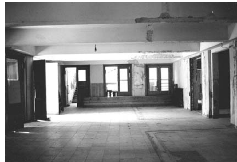
Vorhalle R1.01 (Mai 1996)
