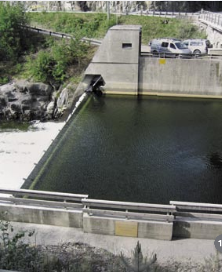
Fra venstre: Strandefjord, montering av spill for tappeluker, 1958. Strandefjord, damluke, 2006.
