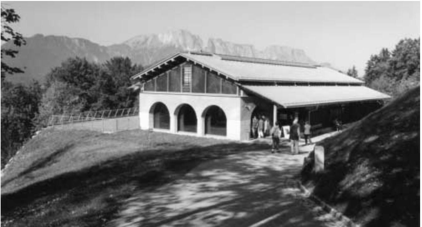
Das Hauptgebäude der Dokumentationsstelle mit neuem Anbau (im Bild links, unter der Terasse)
