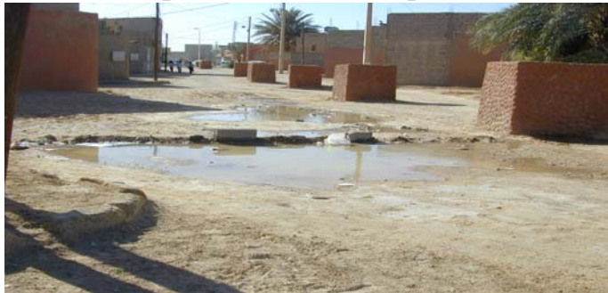
Série de puits de visite- foggara au centre ville d'Adrar
