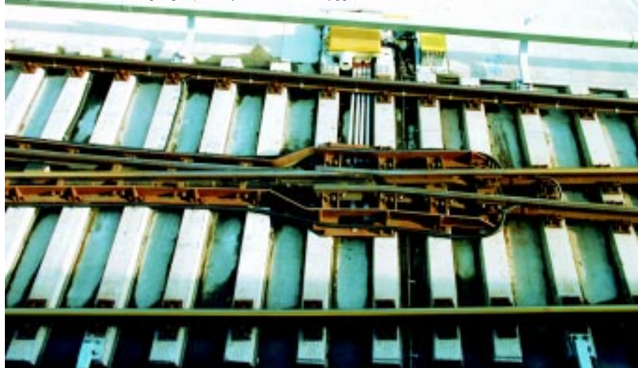
Sporskifte med bevægeligt hjertestykke, Islands Brygge 2002
