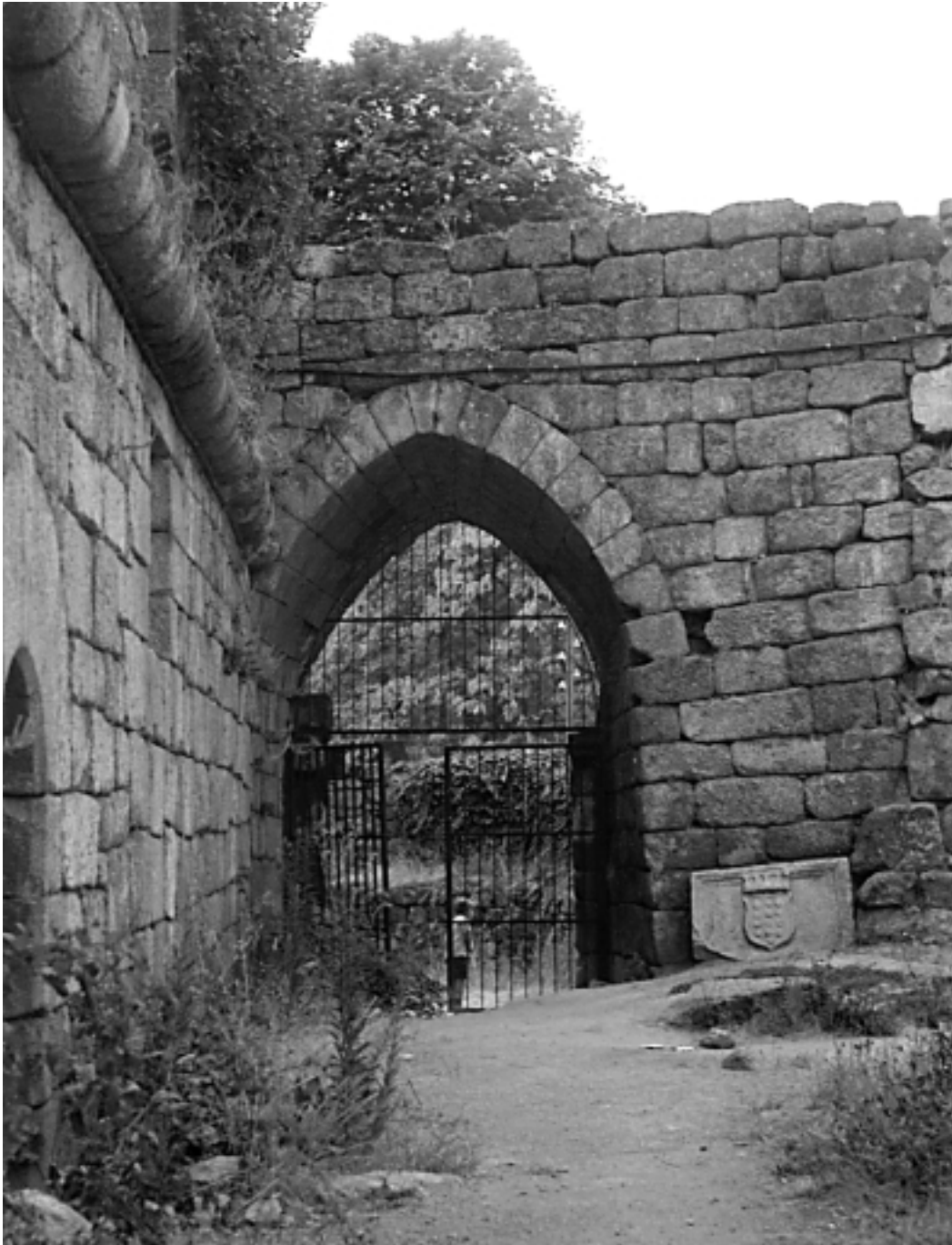
Interior do Castelo dos Condes de Ribadavia, mandado construír por Bernardino Sarmiento, I Conde da Vila.
