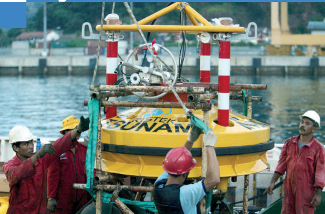
13. April 2007 | Indonesische Ingenieure installieren eine Tsunami-Frühwarn-Boje.
