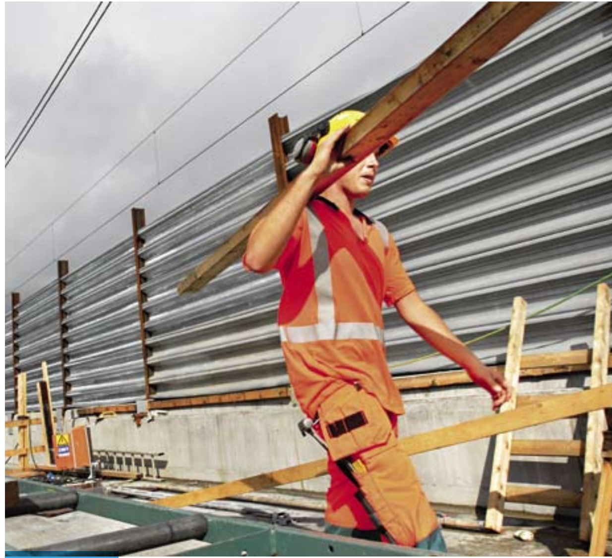
Den største kontrakten for byggingen av stasjonen er utført av firmaet PEAB. På det meste hadde entreprenøren over 300 mann i arbeid. (Foto: Hilde Lillejord)
