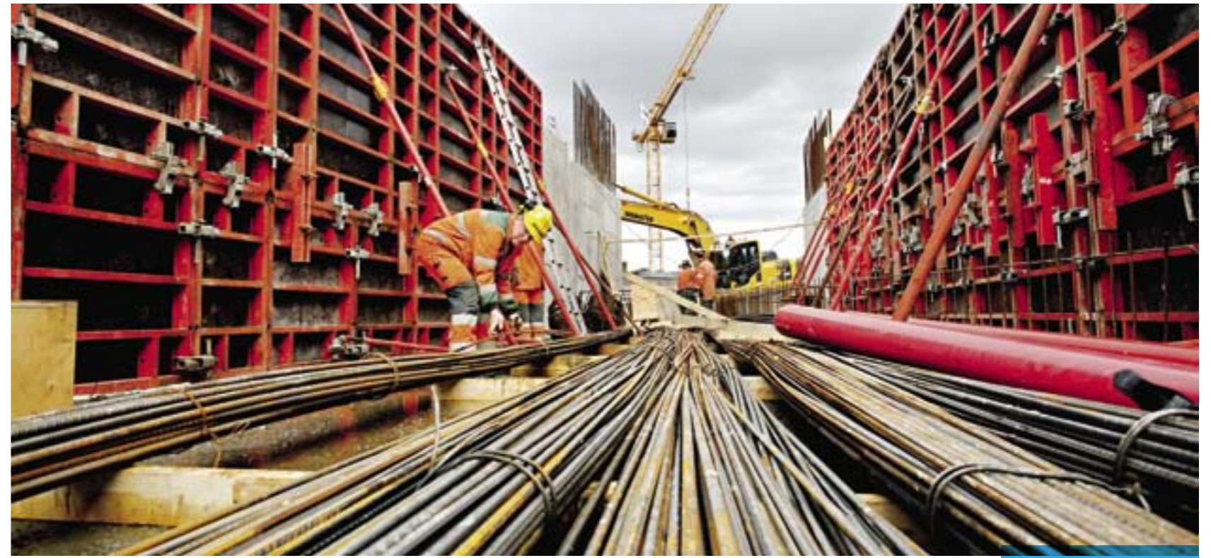
Omfattende betongarbeider er gjort i samband med de nye plattformene og de nye jernbanebrue over Lysakerelva. Til sammen har det gått med over 15.000 m 3 betong og to tusen tonn med armering. (Foto: Hilde Lillejord)
