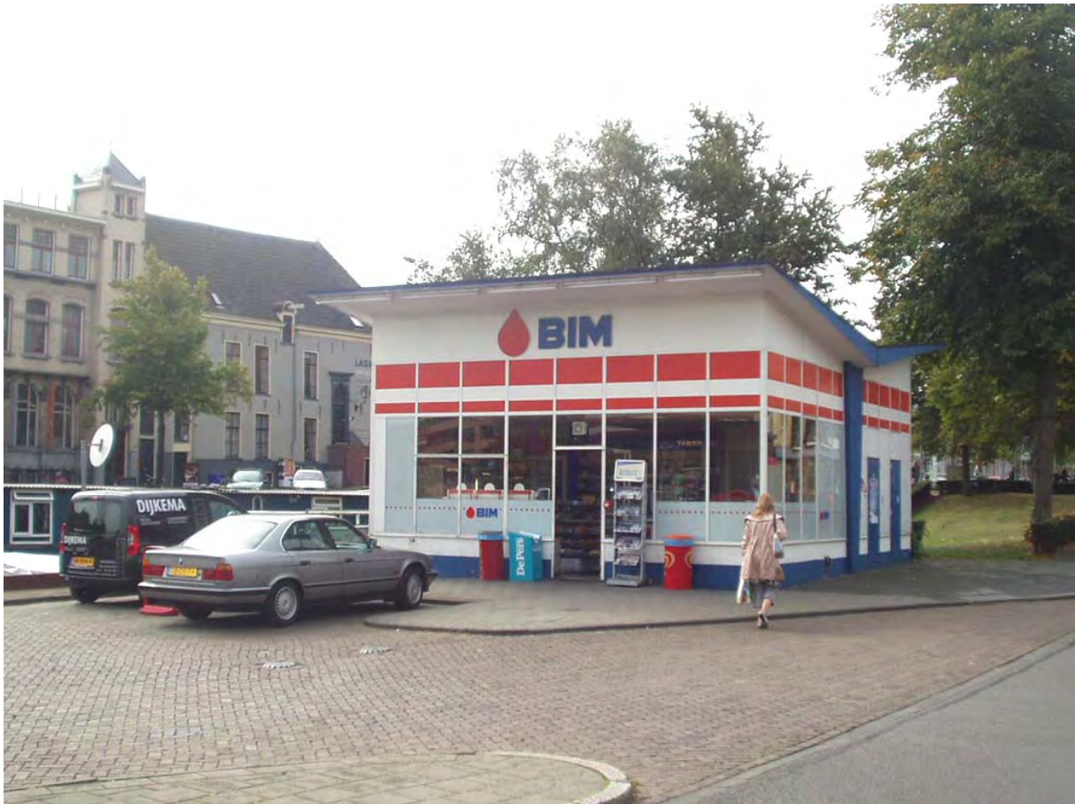
Benzinestation aan de Turfsingel. Dit door Dudok in de jaren '50 ontworpen benzinestation staat op de monumentenlijst. Het is het enige nog in bedrijf zijnde benzinestation van dit type.
