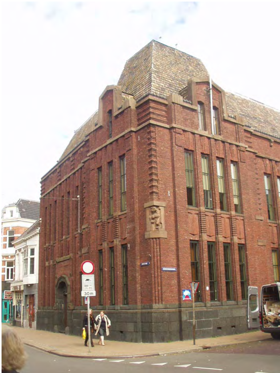
Het van Elmpthuis, hoek Herestraat Herebinnensingel werd in 1928 door Architect Van Elmpt ontworpen voor de Friesch-Groningsche Hypotheekbank. Hier is nu een onderzoeksbureau in gevestigd.
