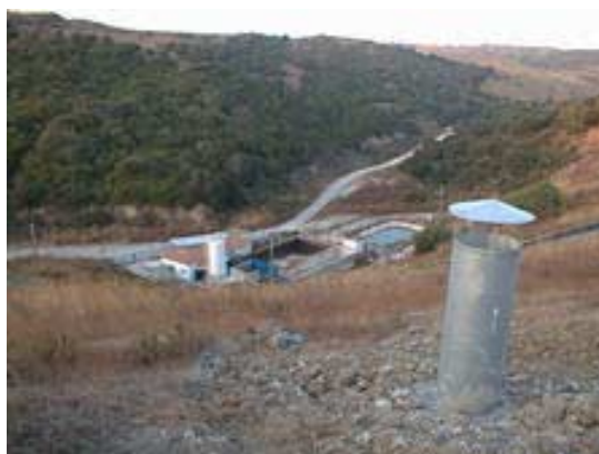
Vista parcial del vertedero mancomunado Los Barrios
