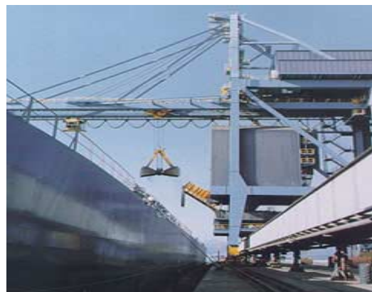
Carga y descarga de graneles sólidos
