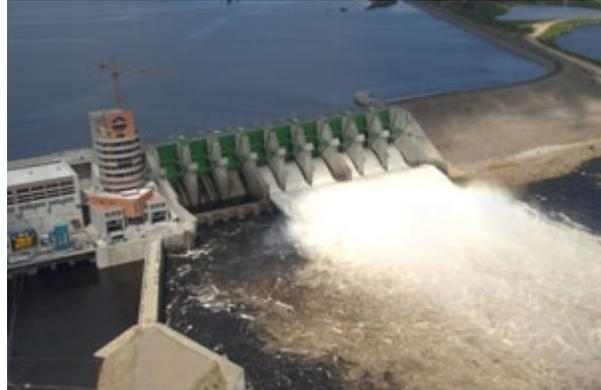
La ubicación de las Presas de tierra y enrocamiento, Aliviadero y Casa de Máquinas obedece a la optimización de las condiciones geológicas, topográficas y energéticas del proyecto.
