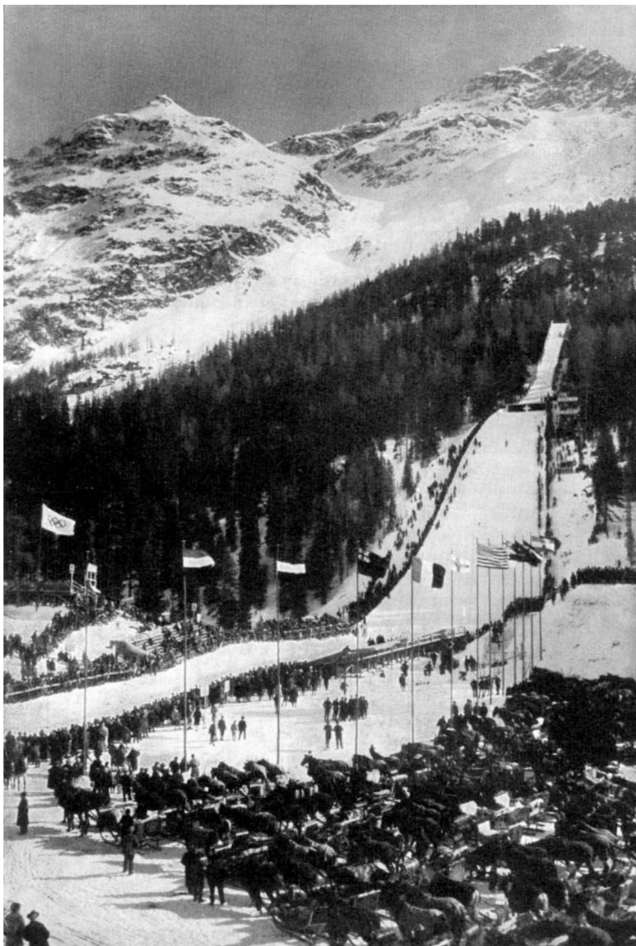
Vue générale du tremplin de saut à Saint-Moritz.
