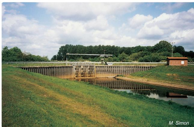
Abb. 4.10-17: Einlauf zum Düker der Löcknitz unter der Müritz-Elde-Wasserstraße
