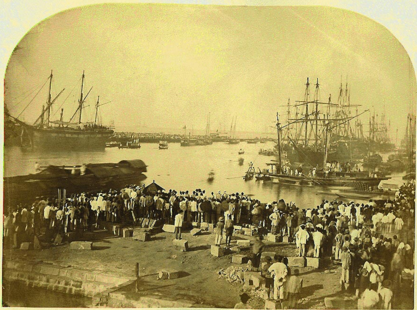
Ejecución de siete piratas en el Malecón del Sur.
