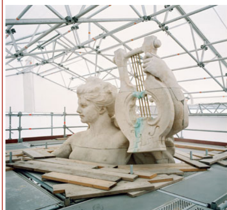
Grand Palais - Restauration des sculptures, façade Est © Patrick Tourneboeuf/06 décembre 2005
