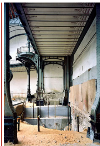
Grand Palais - confortation des fondations, nef sud : paroi moulée © Patrick Tourneboeuf/Sept. 2002
