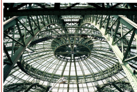
Grand Palais - Pose du pendentif sous le dôme central © Patrick Tourneboeuf/Juillet 2004
