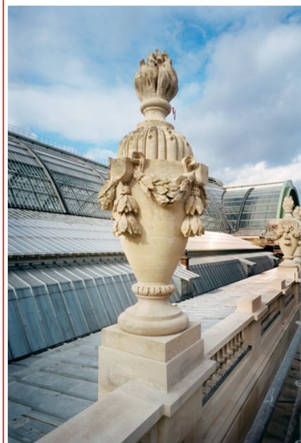
Grand Palais - restauration des façades et des mosaïques. © Patrick Tourneboeuf/janvier 2006
