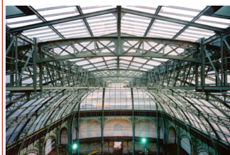
Grand Palais - Vue sur la nef sud restaurée © Patrick Tourneboeuf/Janvier 2004
