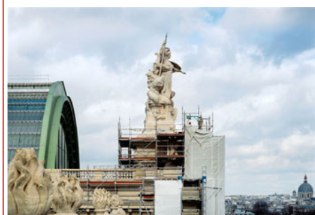
Grand Palais - Restauration des sculptures, façade Est © Patrick Tourneboeuf/26 janvier 2006
