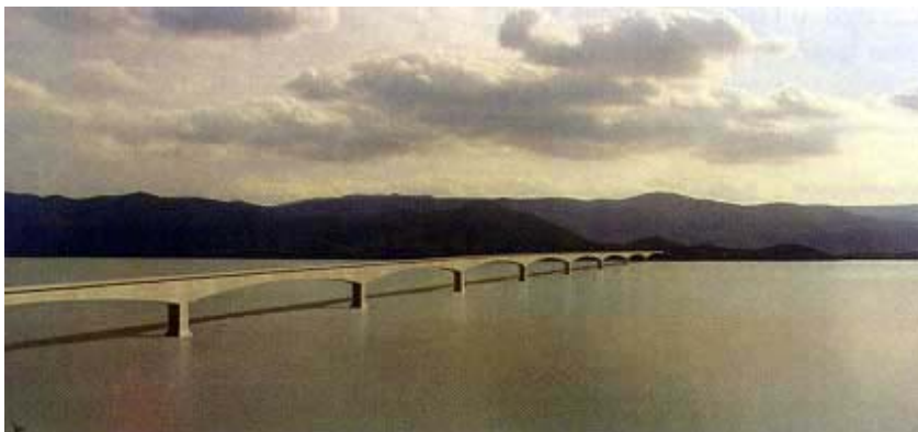
Gredni montažni most kopno (Klek) – Pelješac, pogled s kopna
