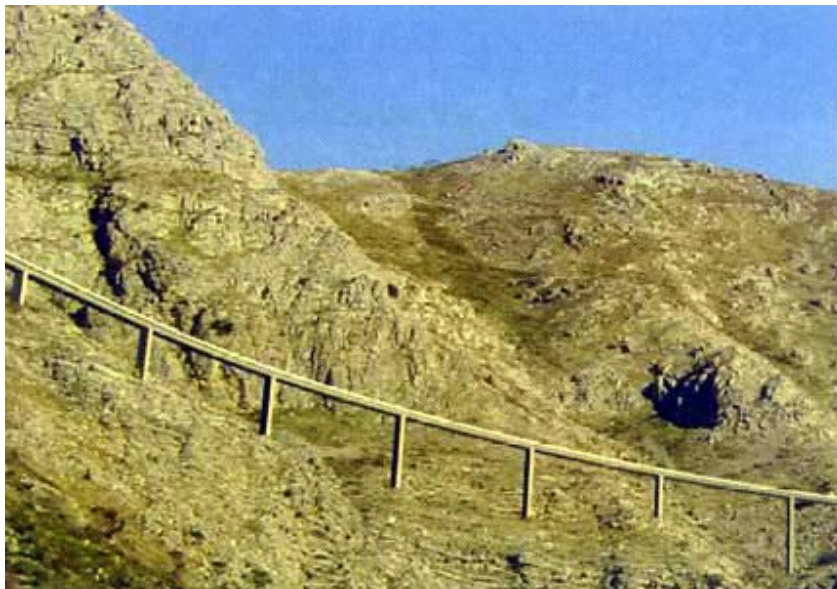
Montažni gredni vijadukt Ombla
