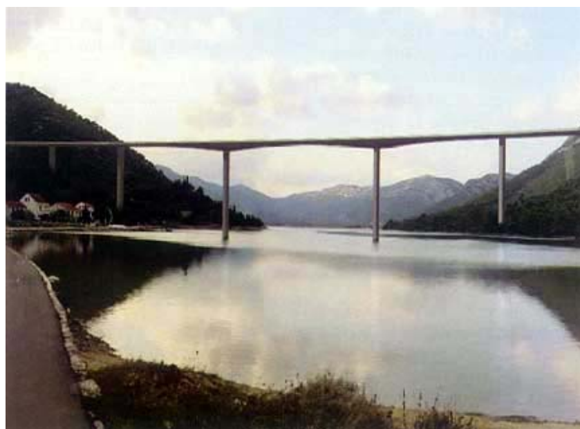
Montažni most preko Malostonskog zaljeva
