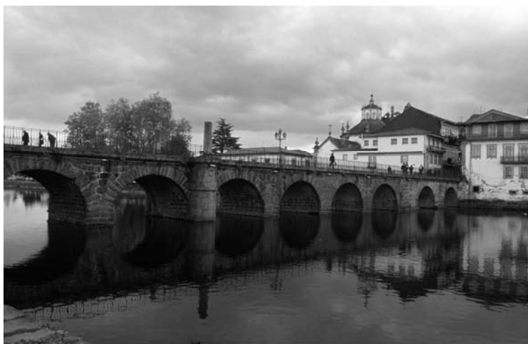
Dois aspectos gerais da ponte.
