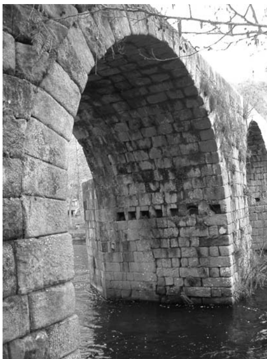
Vista xeral e detalle da ponte de Freixo.
