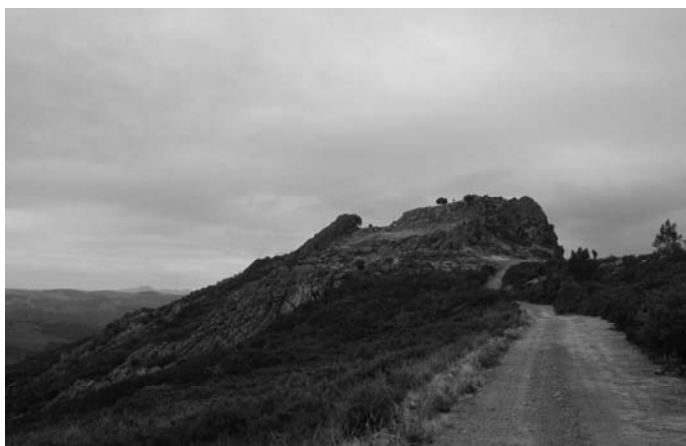
Um aspecto da estação, vista do Noroeste.
