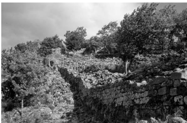
Aspecto parcial da muralha.
