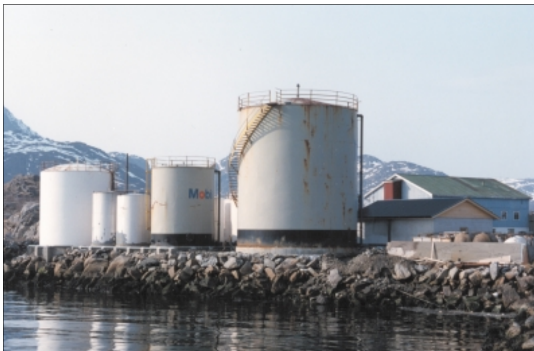
Ensileringsanlegg på Balstad. Gamle oljetanker blir brukt til lagring av ensilasje. (Foto: RUBIN)
