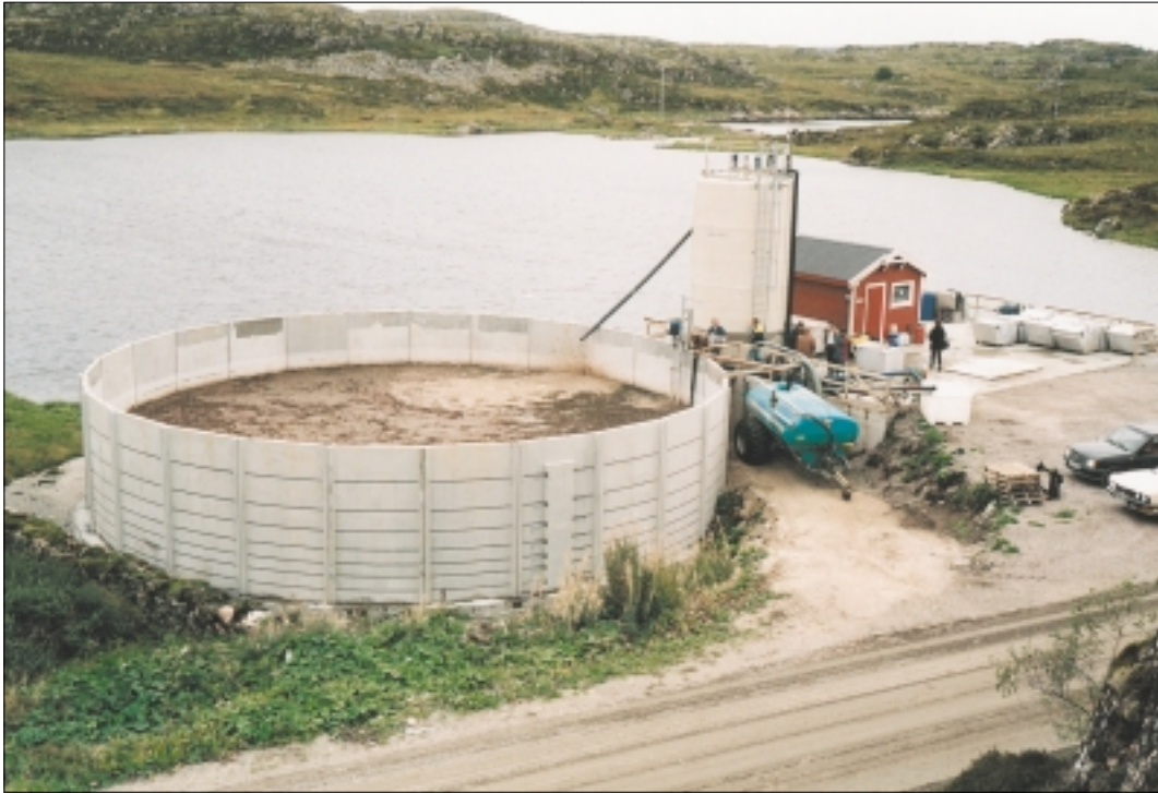
Komposteringsanlegg på Frøya.
