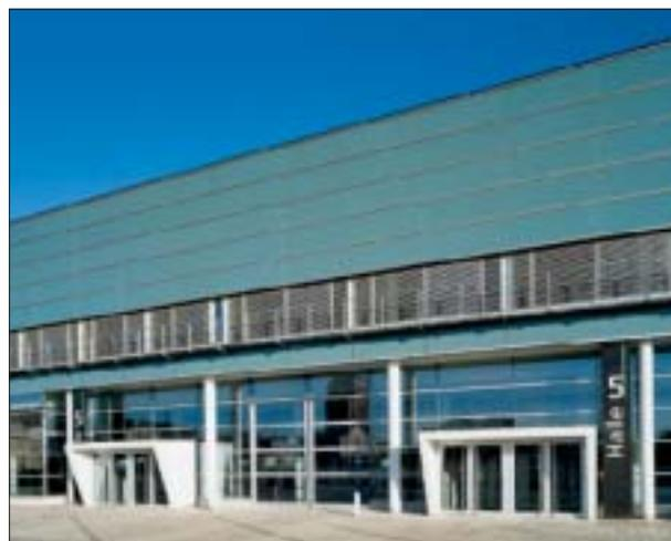
Proportionierung und Anordnung der einzelnen Fassadenelemente, wie Fensterbänder, Tore, Lüftungsgitter und geschlossene Fassadenabschnitte, fest. Durch das Maßverhältnis der Fassadenplatten von 1/2,6 in Höhe zu Breite erfährt die Fassade eine Betonung der horizontalen Linien, die durch die Profilierung der Deckschalen und den Verzicht auf die Abdeckung der vertikalen Plattenstöße noch verstärkt wird.
