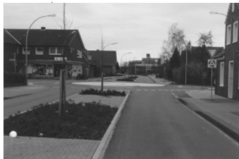
Abb. 2: Aufwendig hergestellter Mini-Kreisel mit 20 m Außendurchmesser und Fahrbahnteilerinseln in Gescher, Krs. Coesfeld
