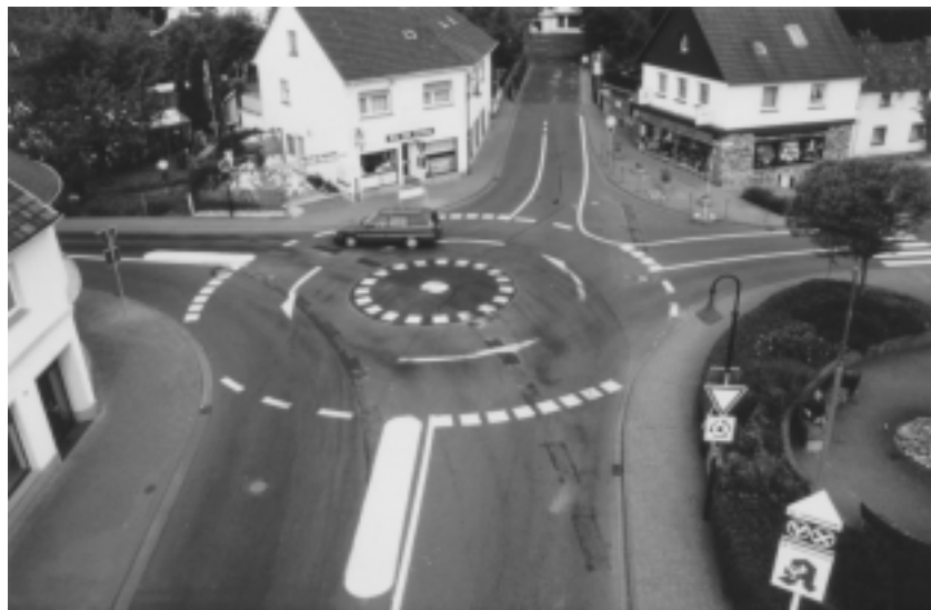
Abb. 1: Mini-Kreisel in einfacher Ausführung in Kall/Eifel (Foto: Straßenbauamt Euskirchen)
